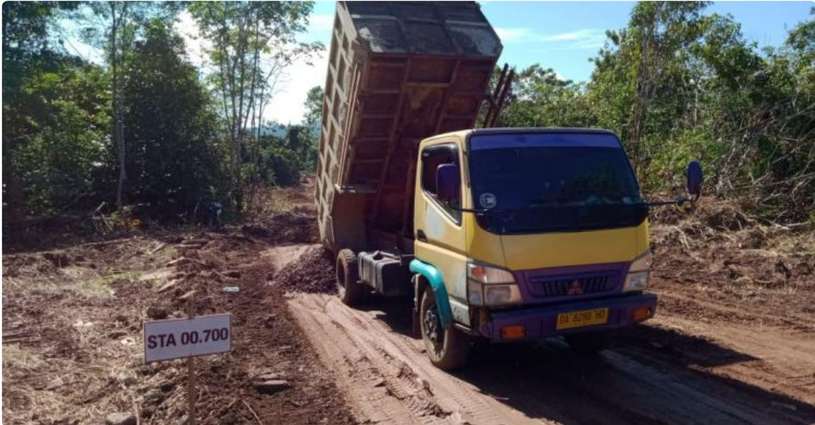
“Kondisi cuaca berpengaruh terhadap kontur tanah membuat badan jalan yang baru dibangun ini sering amblas jika dilalui mobil mengangkut material ke lokasi TMMD.
